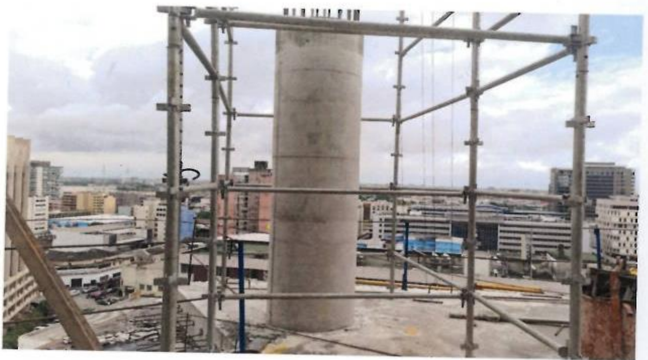
Piliers de structure et mise en place du réseau RIA
