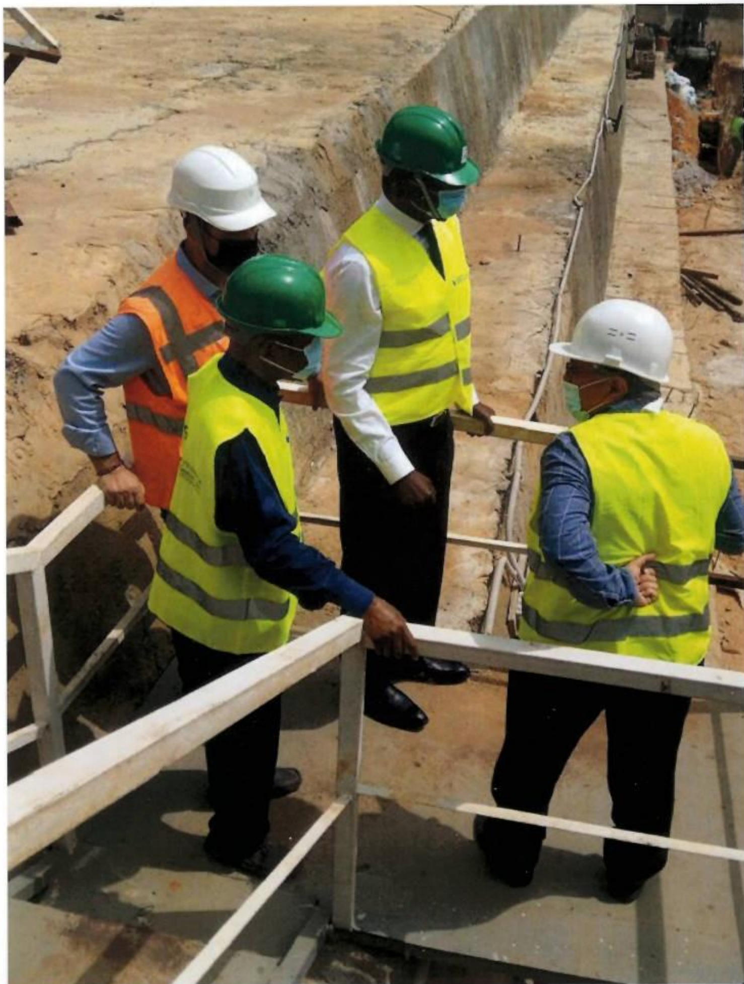
Visite de chantier
