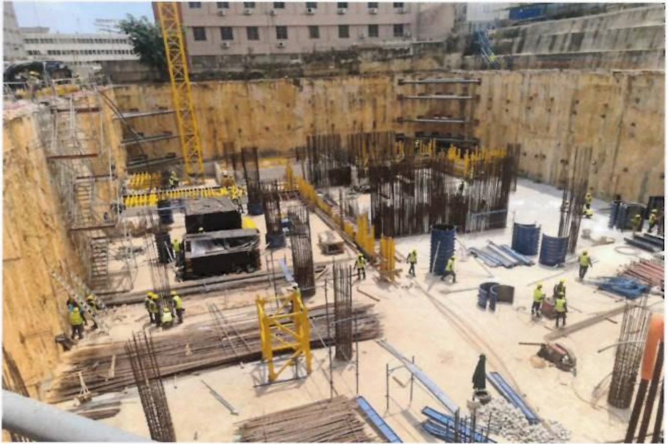
Elevation des sous-sols, parkings et préparation de la rampe d'accès
